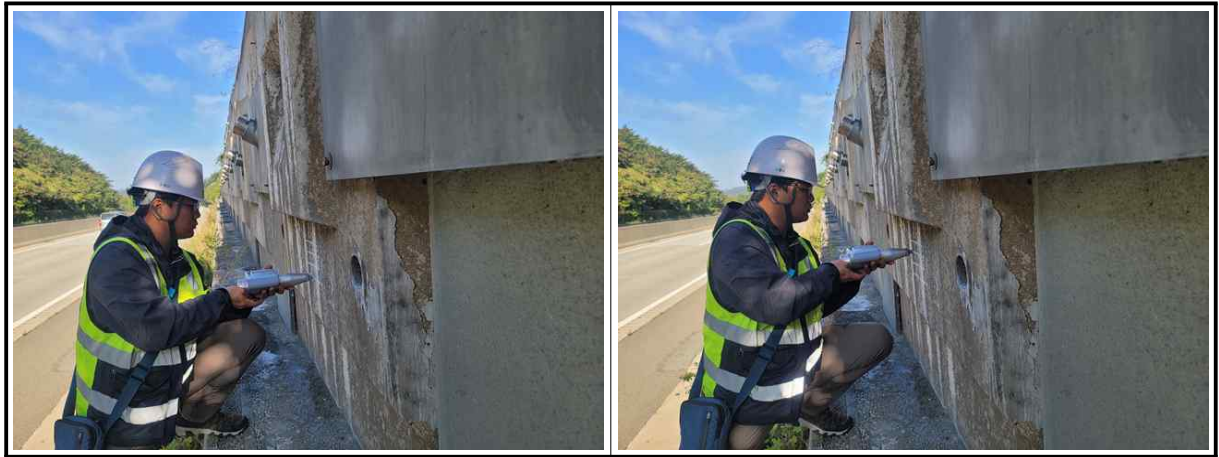
【그림 10.3.6】 슈미트해머를 이용한 반발경도시험 전경
